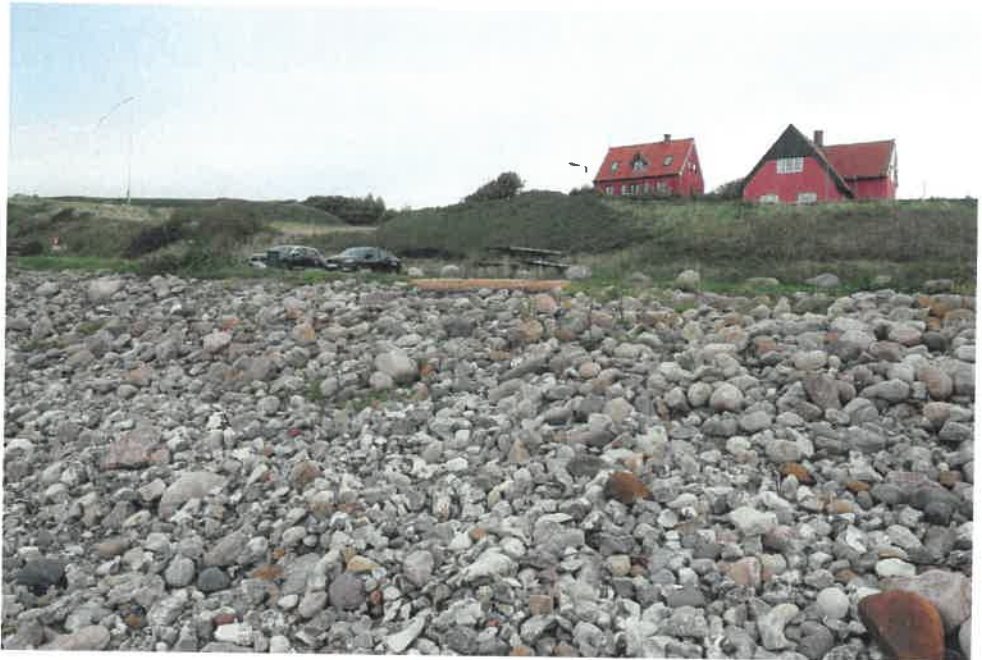
Figur 2-8 Stenkastningen op mod parkeringspladsen.
