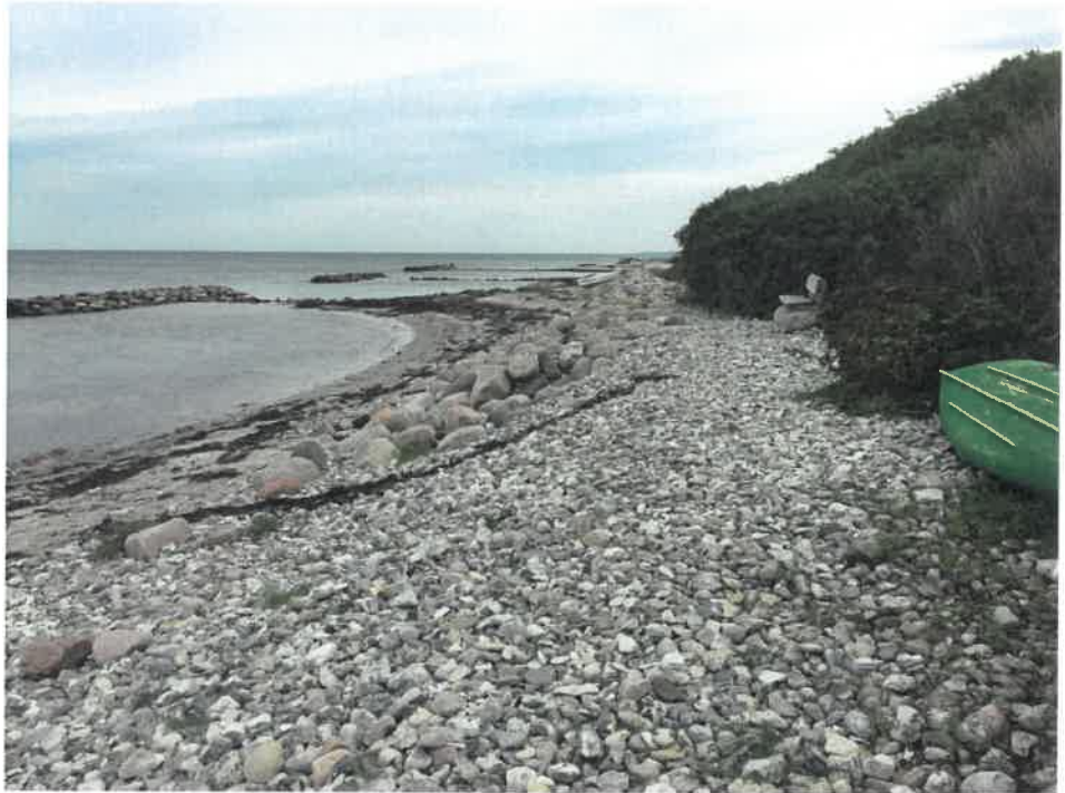
Figur 2-71 Mellem bølgebryder nr. 9 og Linesvej.
