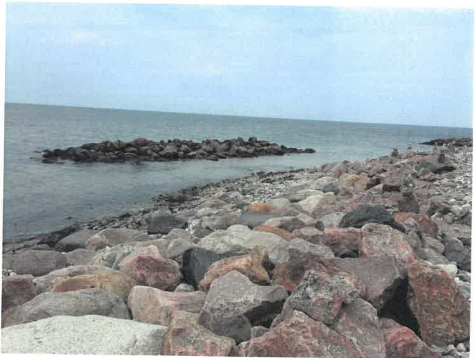
Figur 2-11 Bølgebryder nr. 1 med en del omlægning af dæksten.
