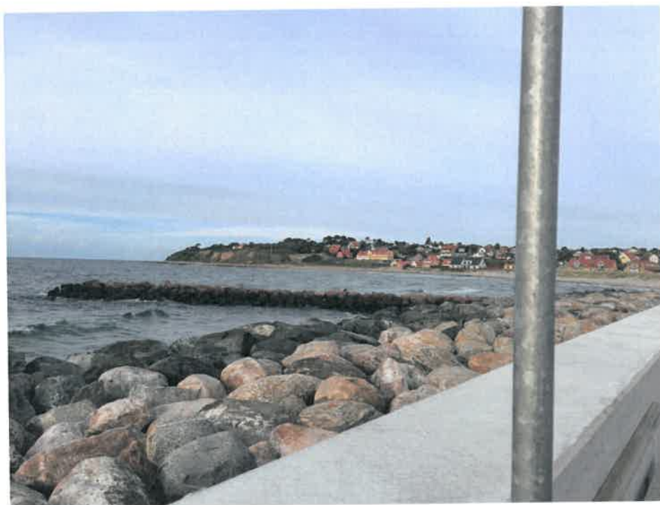
Figur 2-4 Sandfangeren set henover den nye betonbølgeskærm i Hundested Havn (COWI projekt). I baggrunden ses projektstrækningen med bebyggelsen ved Skansevej og Skansen.
