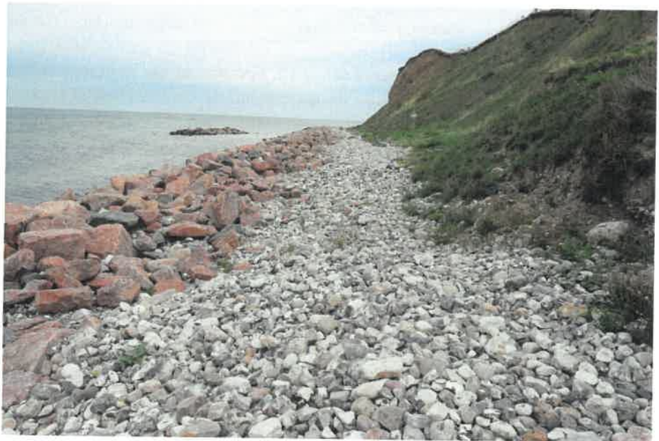
Figur 2-9 Stenkastningen foran Skansen.
