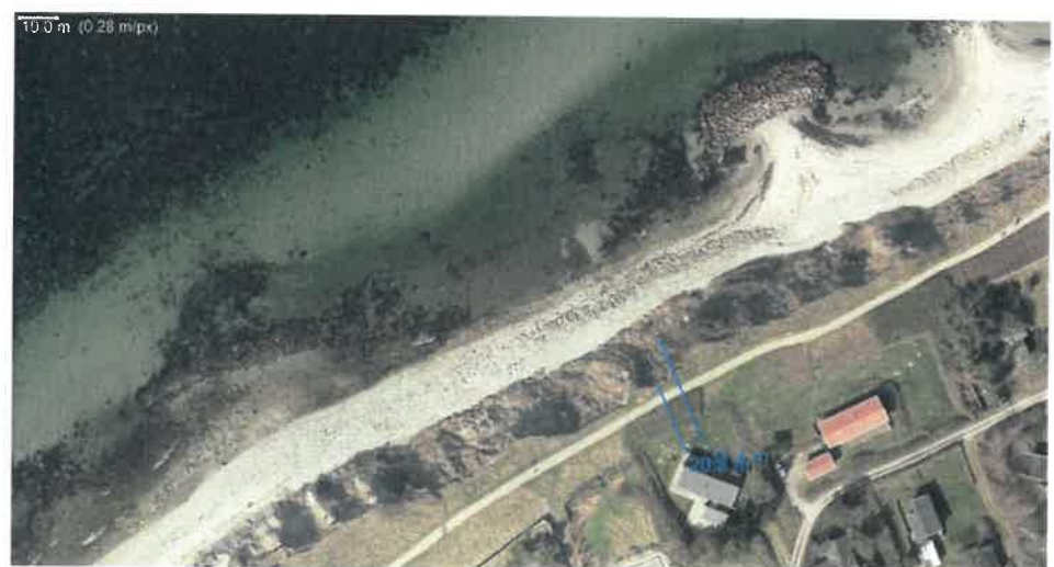
Figur 2-62 Luftfoto fra hhv. 1954 og 2017, der viser en tilbagerykning på ca. 10 m.
